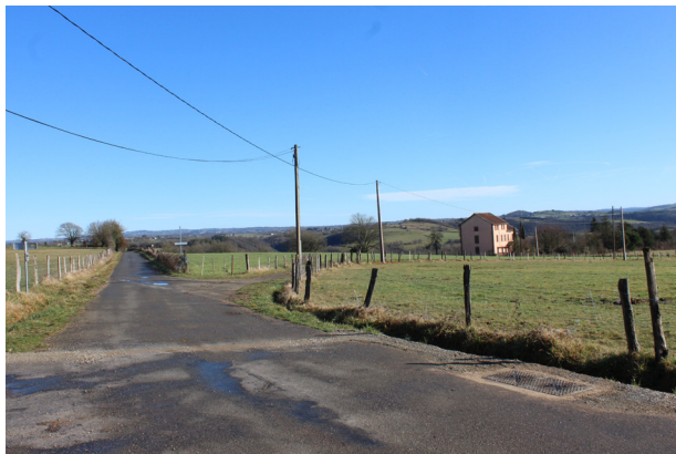
Maisons de garde-barrière dans la campagne du Ségala au sud du Viaduc.
