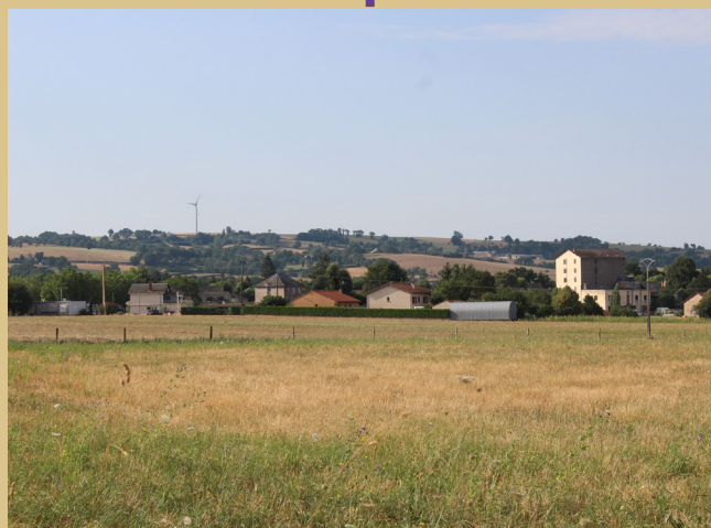
Après : Tanus (sur l'ancienne RN88) développée en plateau, très en marge du pont.
