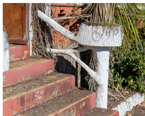
Le bois béton, décors caractéristique de son époque se retrouve sur les gardes-corps de l'ancien hôtel Angles.
