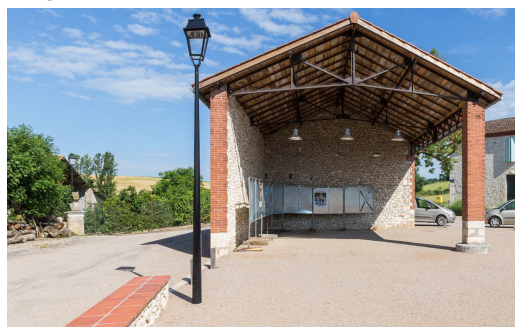
Hangar rénové en halle ouverte à Sainte-Croix (81)
