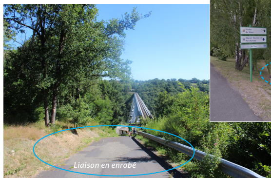
Entrée actuelle, très routière
